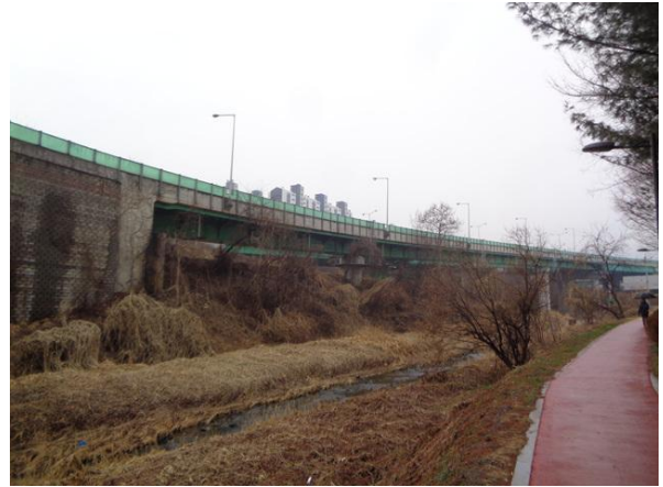
교량 측면 전경
