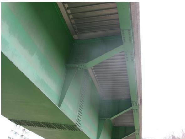
바닥판 하면 및 거더 전경
